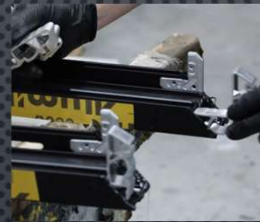
Τοποθέτηση γωνιών σύνδεσης
